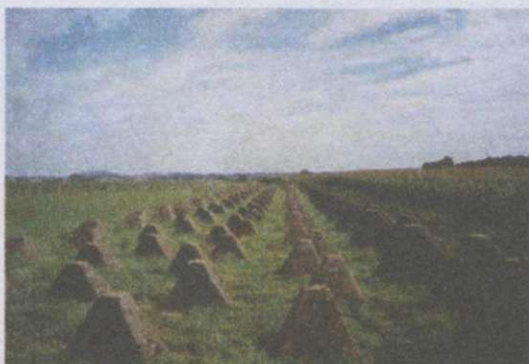
Іл. 17.4. Залізобетонні пірамідальні протитанкові перешкоди
